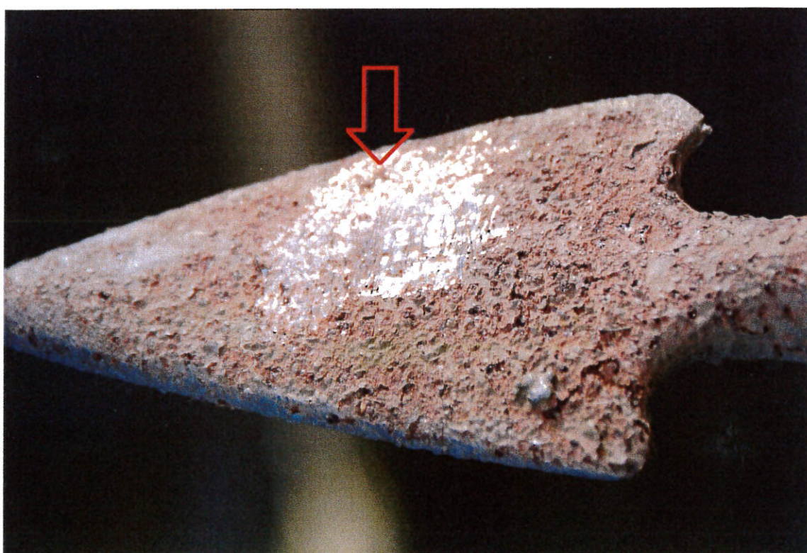
LOKALIZACE: kříž – detail hrotu na ohrádce (2) ETAPA: sonda pod povrchovou korozi – šipka ukazuje na očištěnou litinu
