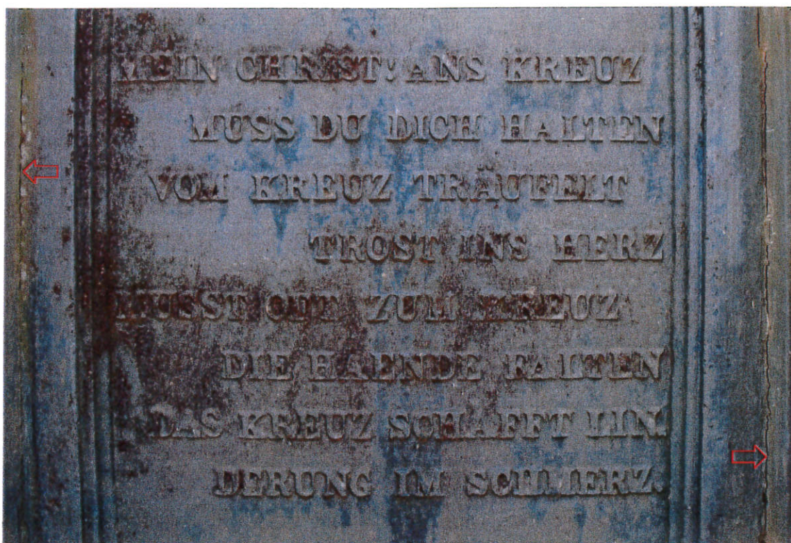
LOKALIZACE: kříž – horní nápis na čelní straně podstavce ETAPA: současný stav – šipky ukazují uvolněné konstrukční spoje
