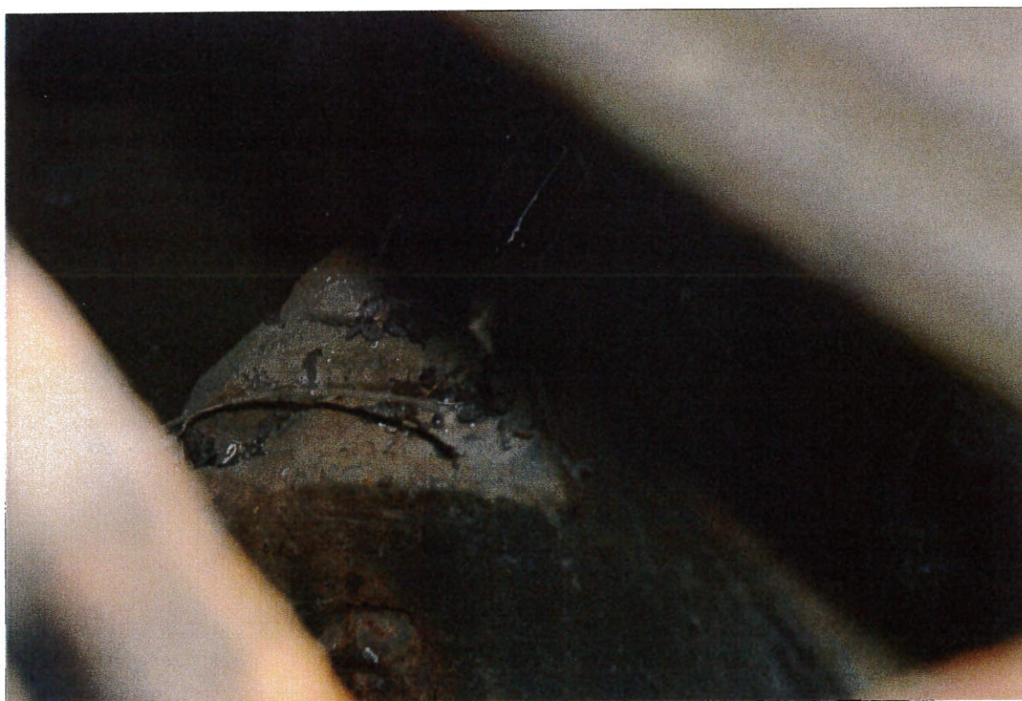
LOKALIZACE: kříž – detail vnitřní nosné konstrukce podstavce ETAPA: optický průzkum ve vychýlených částech podstavce
