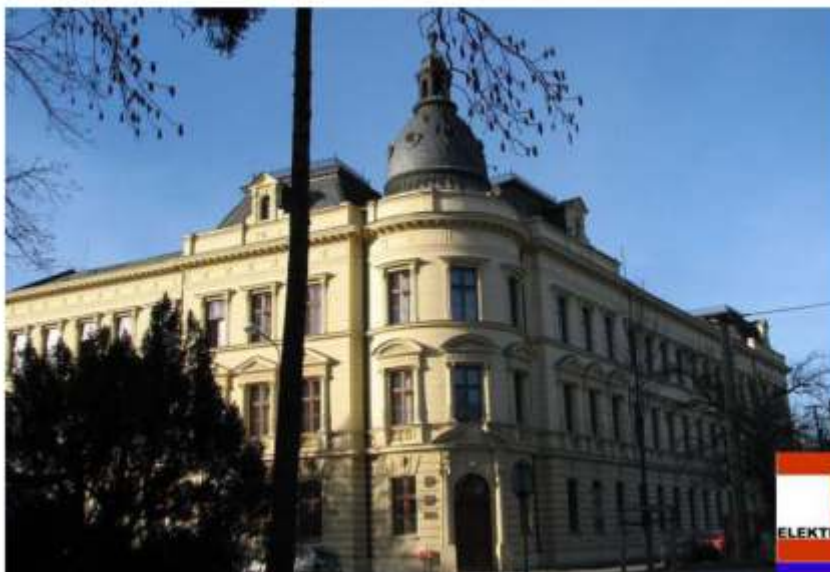
Střední průmyslová škola Stavební Lipník nad Bečvou. 2 x DryPol system 50m Celková cena investice za stavbu = 86.310,- Kč vč. DPH s služeb.
